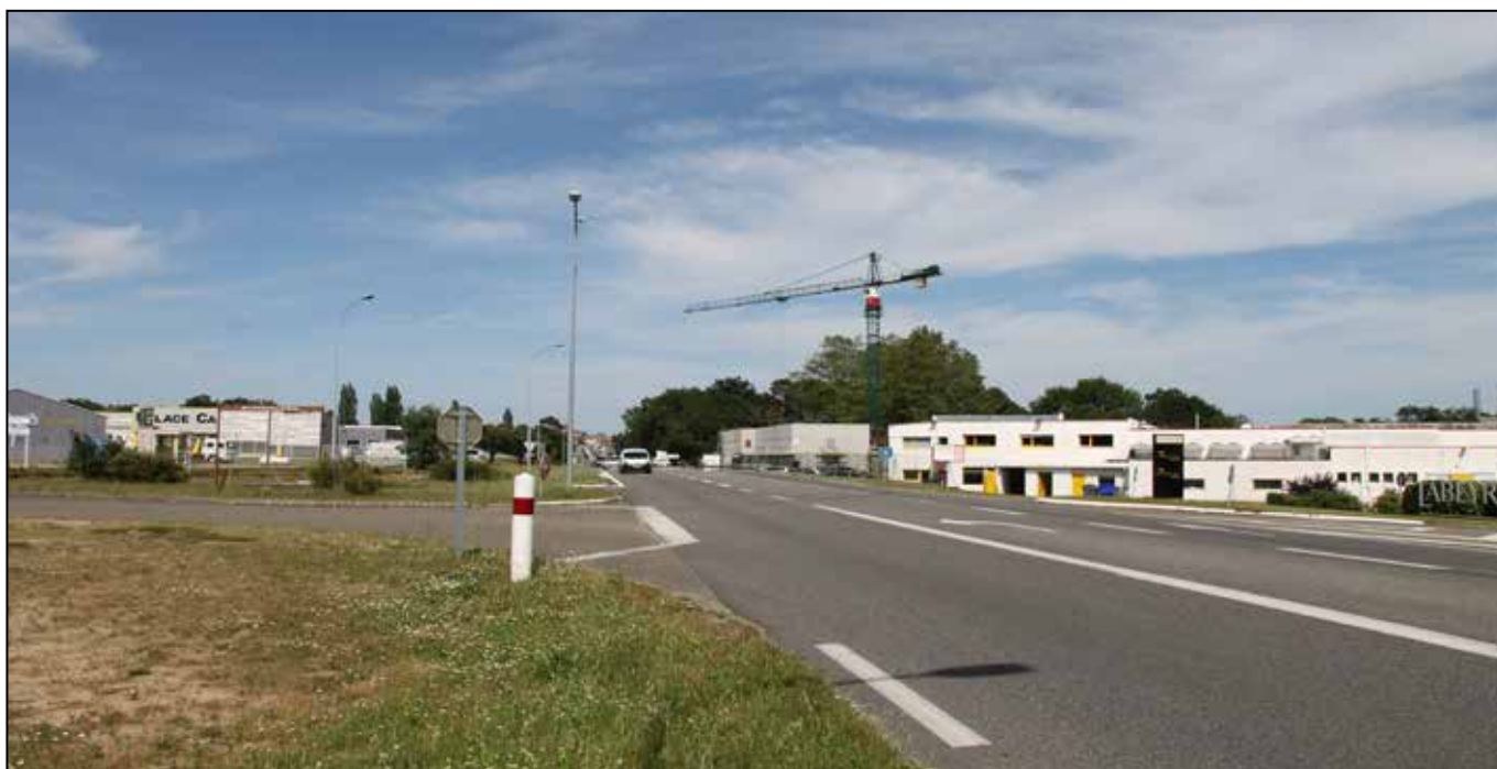
Saint-Geours-de-Maremne : abords de l'usine Labeyrie
