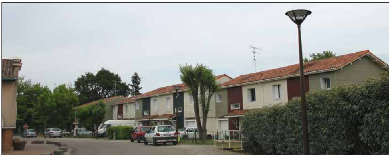
Logements récents au Muret
